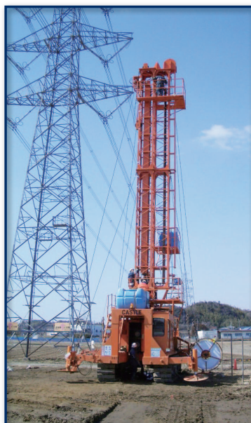
継杭打設式ドレーン打設機
